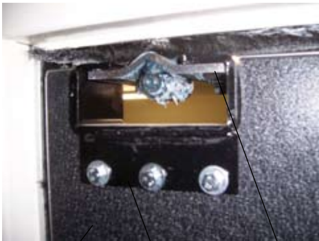
Door Panel Top Hinge Top Hinge Pivot Plate
