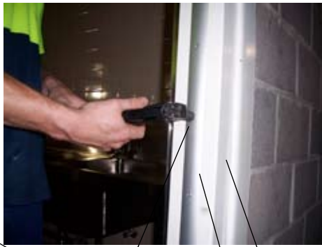
Pop Rivet Seal To Door Frame Dome Seal Door Frame
